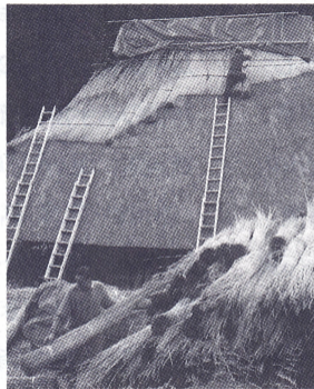
足場よりも、早く簡単に作業が出来る梯子を使う。屋根の横棒は「Sway」という9mmの鉄棒。
